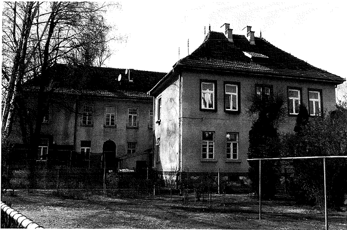
Fot. 6. Kraków, ul. Babińskiego 29, budynek nr 19, elewacja wschodnia segmentu I, elewacja południowa i wschodnia segmentu II.
