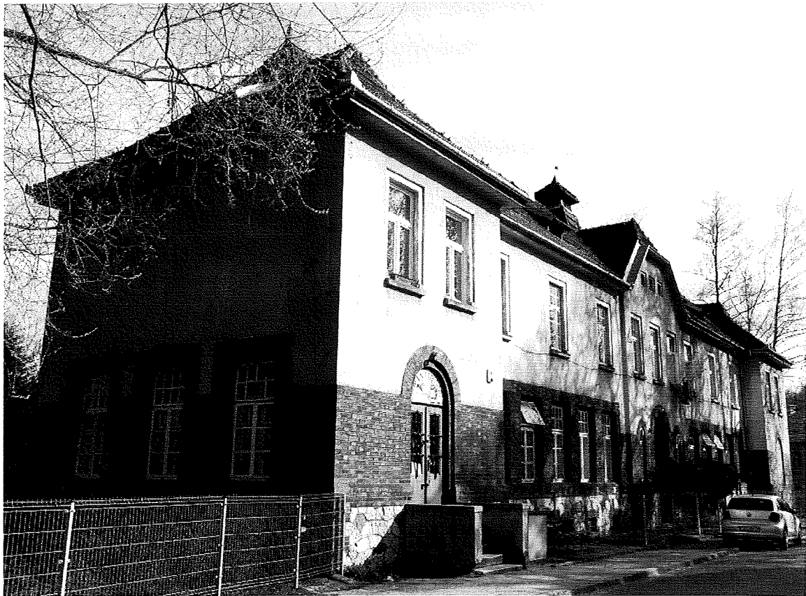
Fot. 10. Kraków, ul. Babińskiego 29, budynek nr 19, elewacja północna i zachodnia (segment I).
