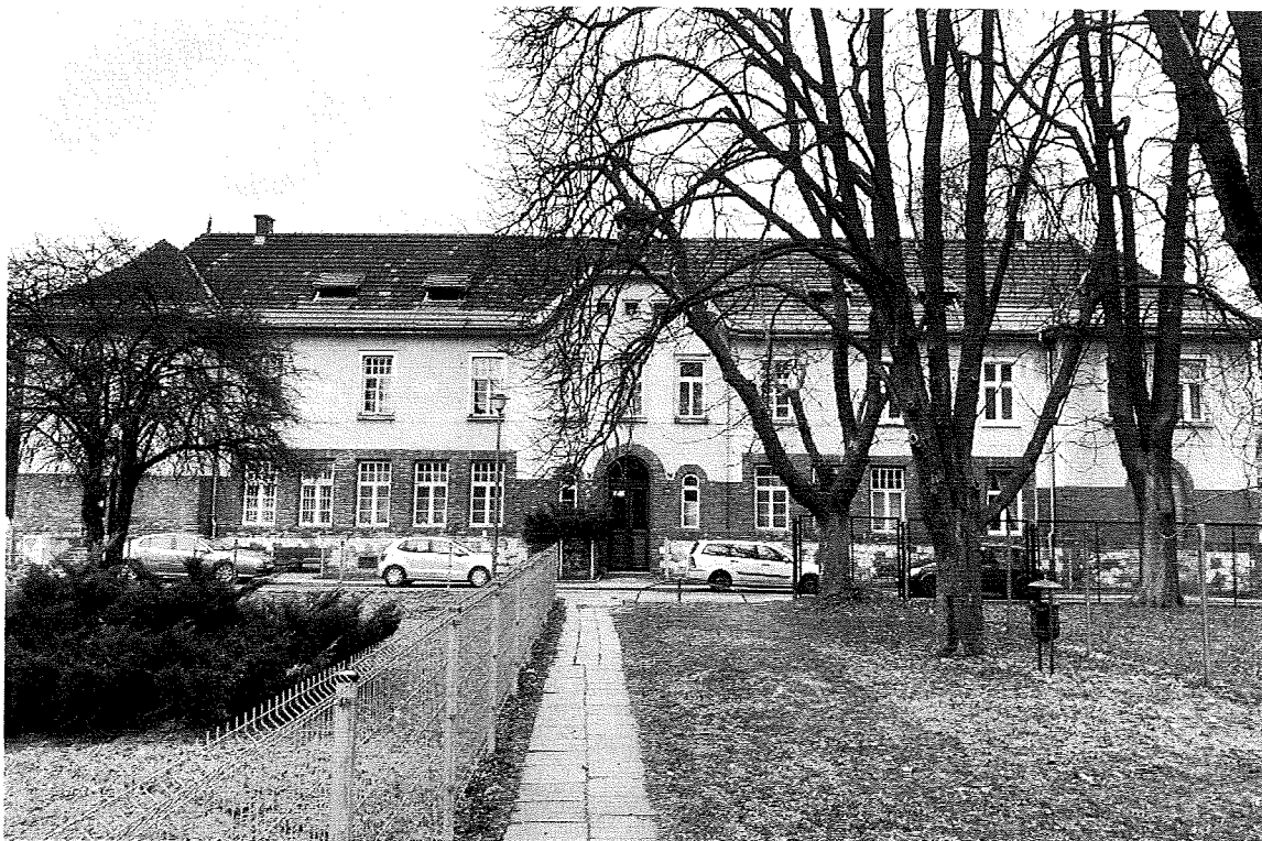
Fot. 2. Kraków, ul. Babińskiego 29, budynek nr 19, elewacja zachodnia (segment I).
