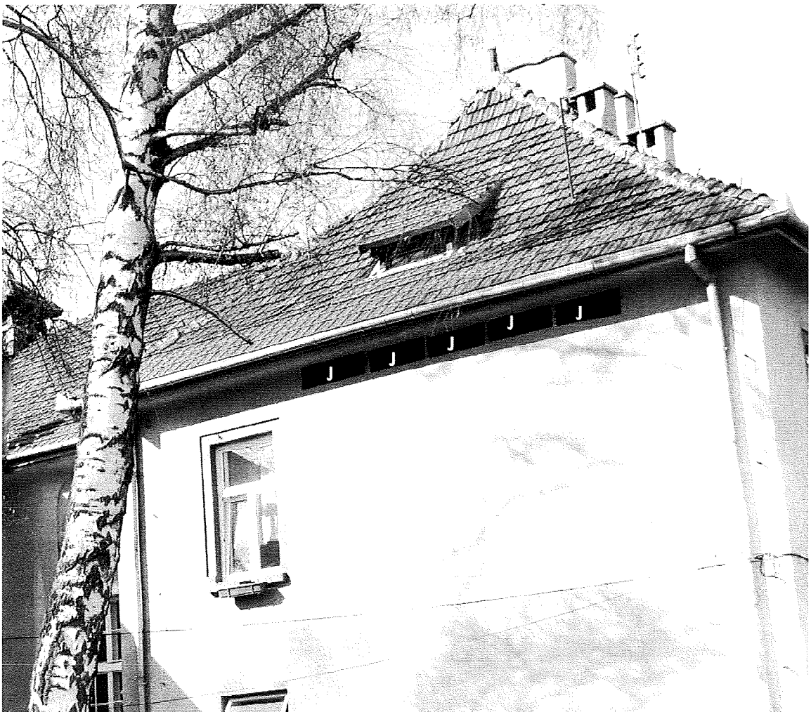
Fot. 13. Kraków, ul. Babińskiego 29, budynek nr 19, ściana południowa segmentu II, pięć czarnych czworokątów z literą J wskazuje miejsca zamocowania podwójnych budek z okapem dla jerzyków.
