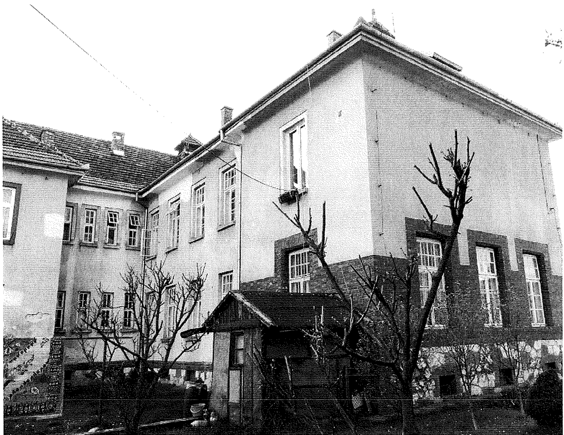
Fot. 9. Kraków, ul. Babińskiego 29, budynek nr 19, elewacja północna segmentu II, elewacja wschodnia i północna segmentu I.
