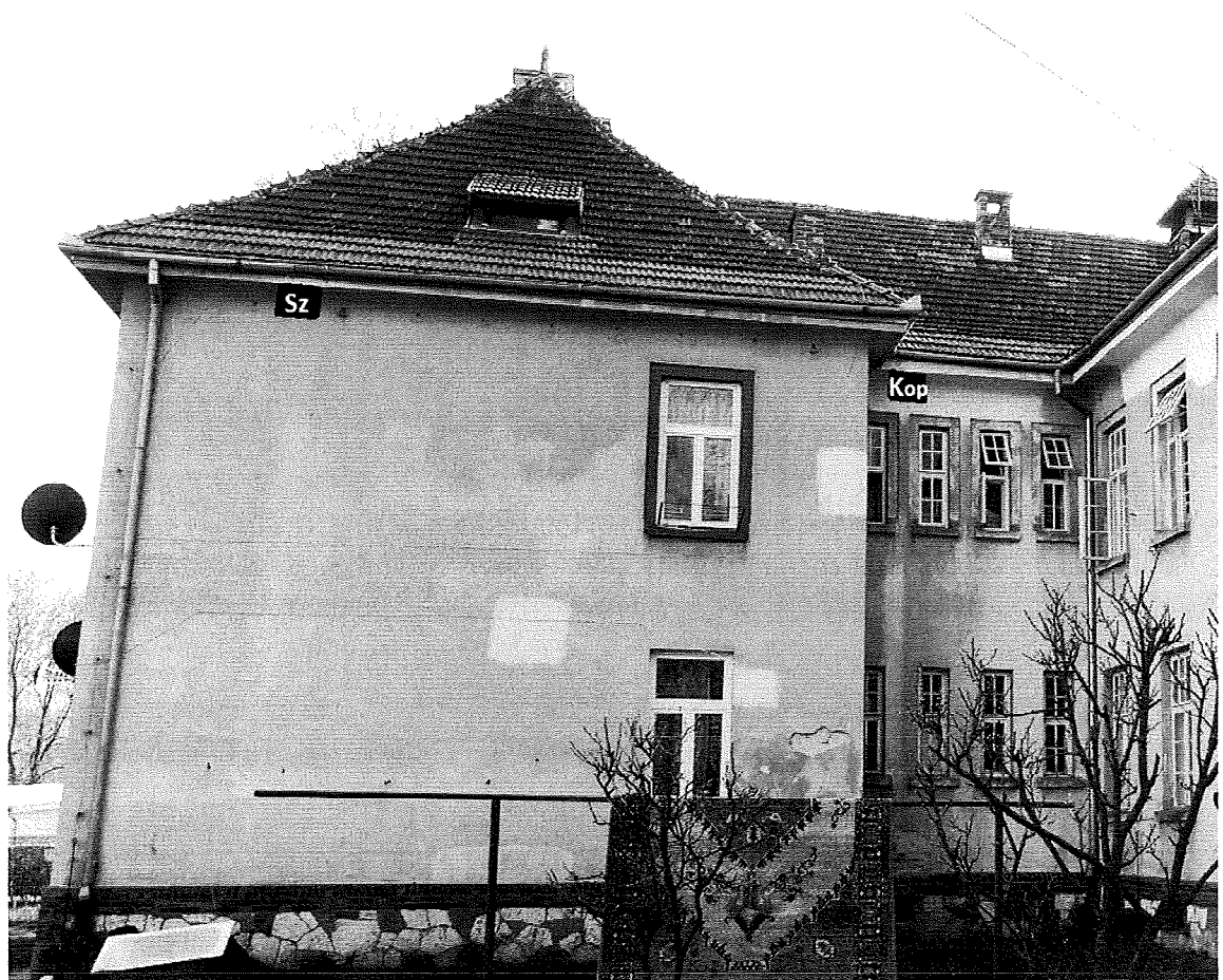
Fot. 15. Kraków, ul. Babińskiego 29, budynek nr 19, elewacja północna segmentu II, czarny czworokąt z literami Sz wskazuje miejsce zamocowania budki z blachą dla szpaków, czarny czworokąt z literami Kop wskazuje miejsce zamocowania budki dla kopciuszków.
