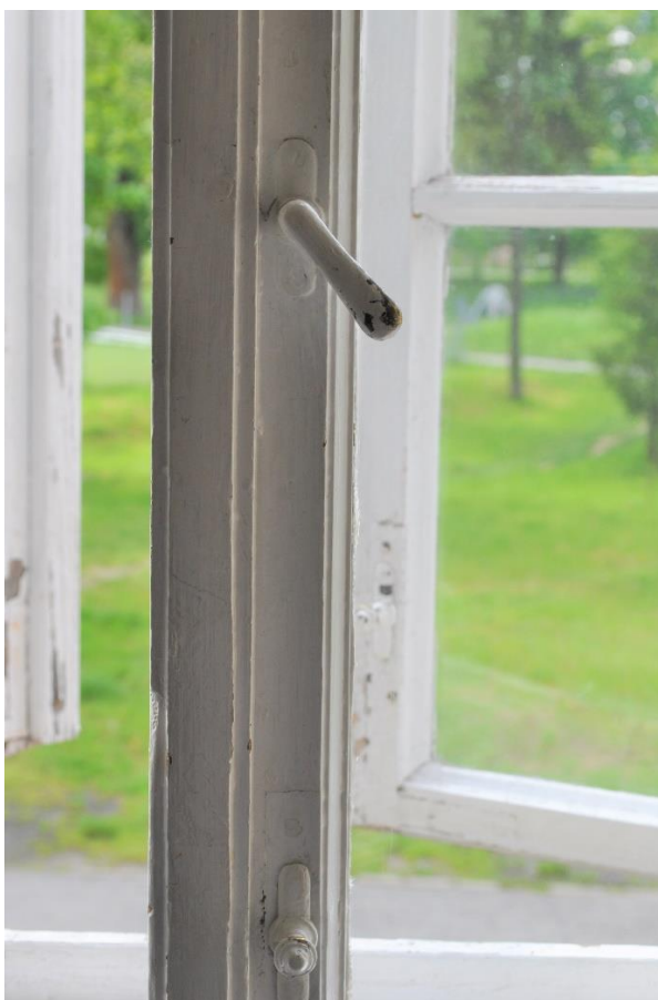
Fot.18 i 19. Góra: skrzydło zewnętrzne okna na elewacji tylnej w stanie degradacji. Dół: pierwotne klamki i zasuwka okna od strony wewnętrznej klatki schodowej. Maj 2021 r. aut. N. Soran - Maluty
