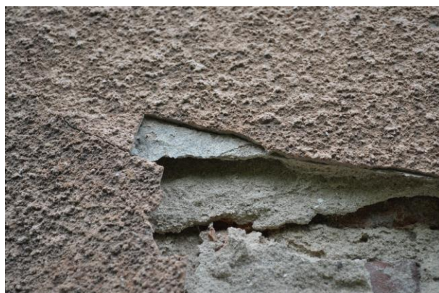
Fot.1. Fragment odkrywki naturalnej na elewacji tylnej budynku nr 20. Widoczne nawarstwienia. Maj 2021r. aut. N. Soran - Maluty
