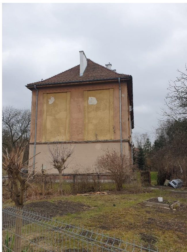
Fot. 29 i 30. Góra: elewacja boczna, zachodnia. Dół: elewacja boczna, wschodnia. Na elewacjach widoczne podwójne, pionowe płyciny o zdwojonych uskokowo bocznych brzegach. Maj 2021r. aut. N. Soran – Maluty
