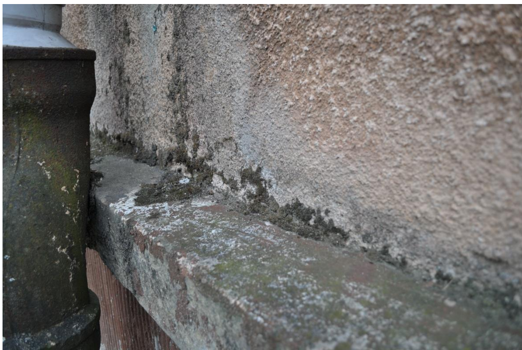
Fot.10 i 11. Góra: zielone porosty na stale zawilgoconej powierzchni. Dół: zawilgocone i porośnięte zielenią otoczenie nieuszczelnej rury spustowej, w dolnej części żeliwnej, jeszcze pierwotnej, górna część wtórna, z blachy. Maj 2021r. aut. N. Soran – Maluty.
