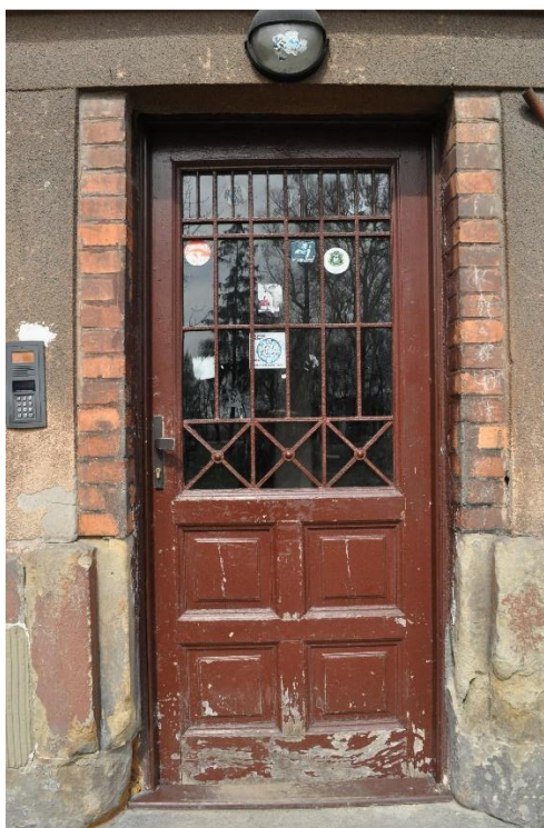
Fot. 6 i 7. Góra: widok drzwi do budynku nr 20 w prawym ryzalicie, w naturalnych odkrywkach w dolnej części drzwi oraz przy klamce ustalono istniejącą stratygrafię. Dół: odkrywka przy klamce od strony zewnętrznej drzwi. Maj 2021r. aut. N. Soran- Maluty.
