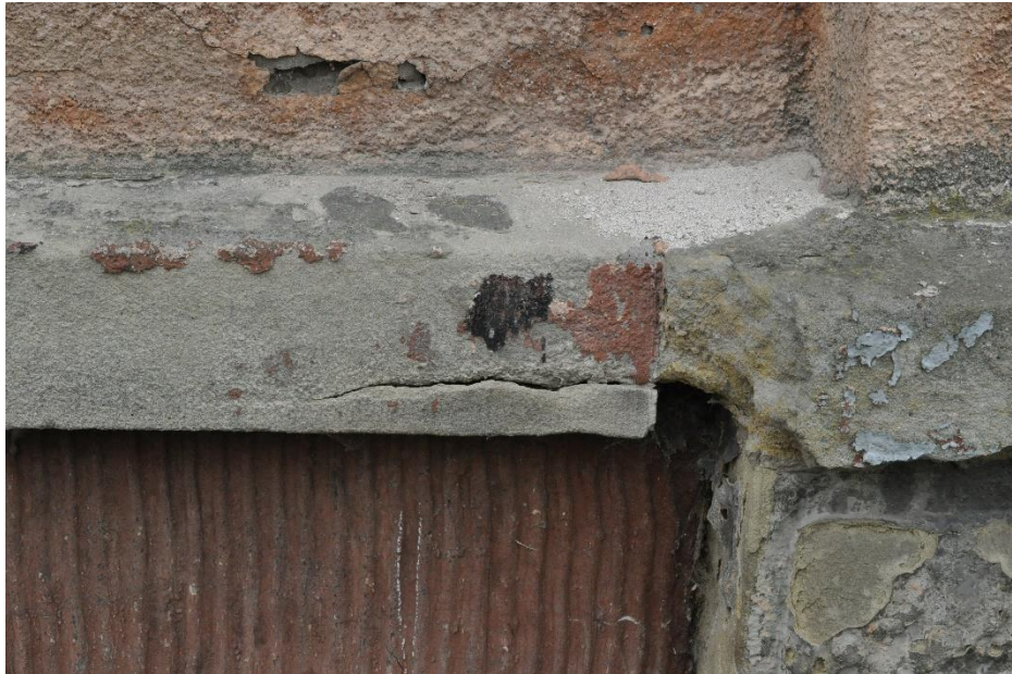
Fot.15 i 16. Góra: fragment cokółu na elewacji tylnej budynku nr 20 . Widoczny zdegradowany piaskowiec ze śladami przemalowania olejną farbą, który okala płytę z betonu z ornamentem w formie grzebykowania pionowego. Grzebykowanie przemalowane na kolor brązowy. Dół: widok ogólny cokółu. Maj 2021r. aut. N. Soran – Maluty.
