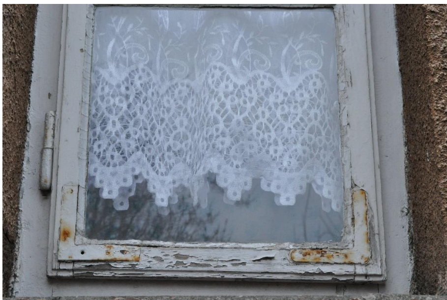
Fot.18 i 19. Góra: skrzydło zewnętrzne okna na elewacji tylnej w stanie degradacji. Dół: pierwotne klamki i zasuwka okna od strony wewnętrznej klatki schodowej. Maj 2021 r. aut. N. Soran - Maluty
