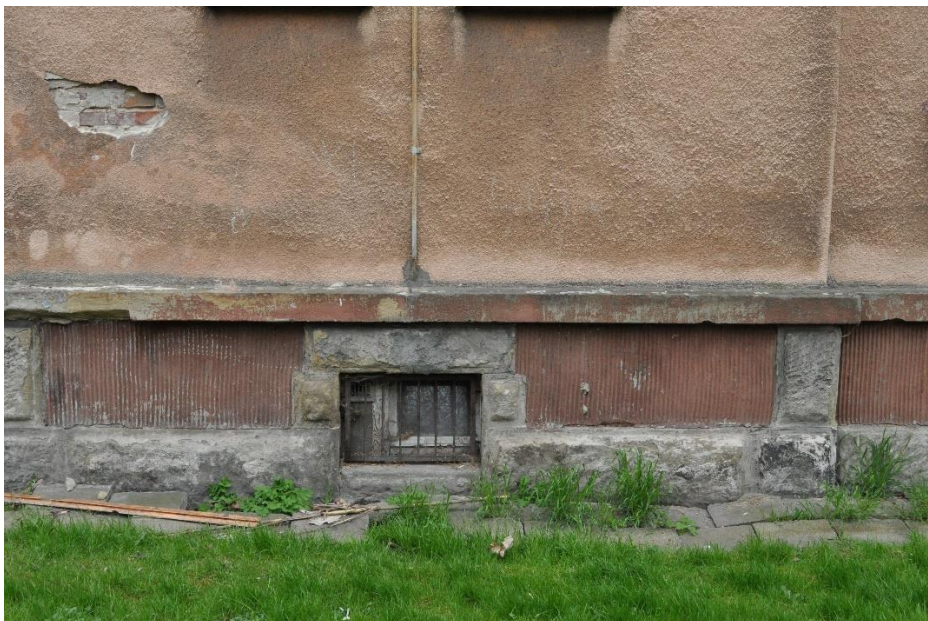
Fot.15 i 16. Góra: fragment cokółu na elewacji tylnej budynku nr 20 . Widoczny zdegradowany piaskowiec ze śladami przemalowania olejną farbą, który okala płytę z betonu z ornamentem w formie grzebykowania pionowego. Grzebykowanie przemalowane na kolor brązowy. Dół: widok ogólny cokółu. Maj 2021r. aut. N. Soran – Maluty.
