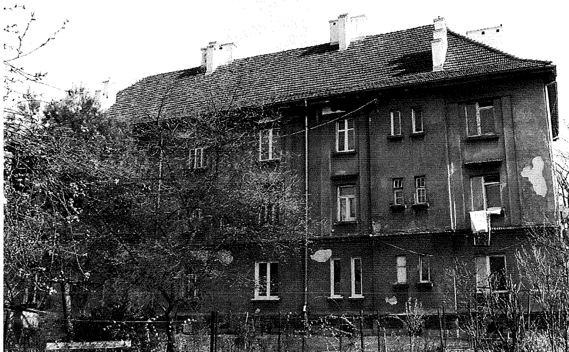
Fot. 5. Kraków, ul. Babińskiego 29, budynek nr 20, elewacja północna.
