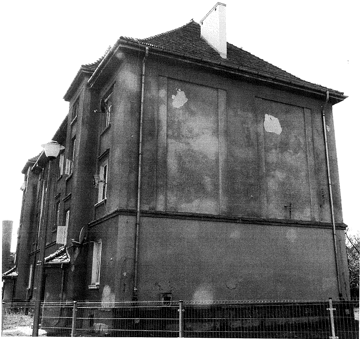
Fot. 3. Kraków, ul. Babińskiego 29, budynek nr 20, elewacja południowa i wschodnia.
