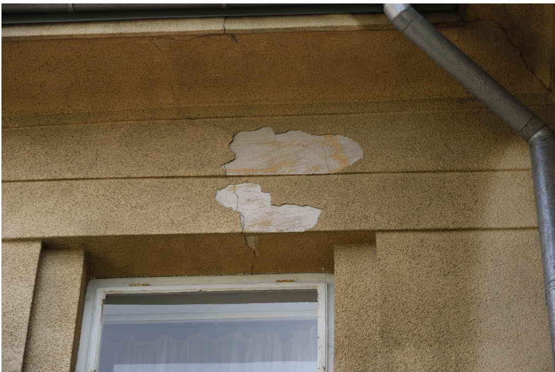
Fot. nr 19 Szpital Kliniczny im. Dr. J. Babińskiego w Krakowie, budynek nr 23. Elewacja północna. Zbliżenie naturalnej odkrywki nad oknem I piętra. Widoczna powierzchnia gładkich pierwotnych tynków. Stan przed konserwacją. Kraków, kwiecień 2023 r. fot. K. Sułkowska
