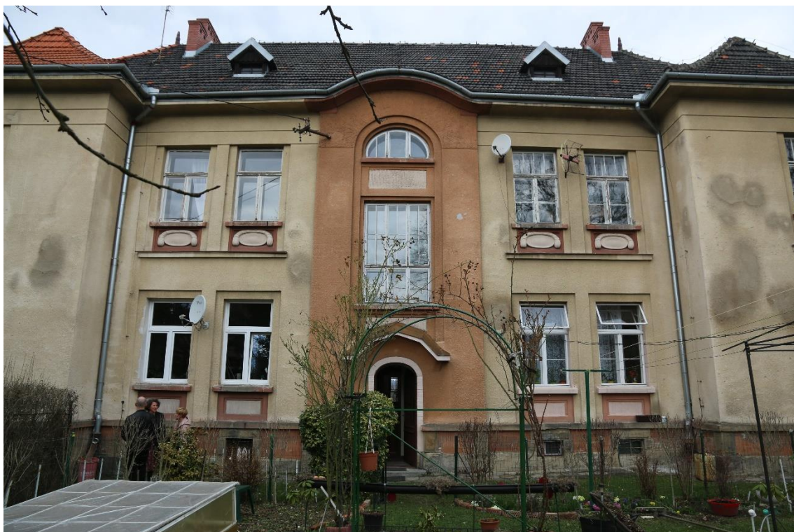
Fot. nr 27 Szpital Kliniczny im. Dr. J. Babińskiego w Krakowie, budynek nr 23. Widok ogólny środkowej części elewacji południowej. Widoczna zachowana pierwotna stolarka okienna w osi środkowej oraz na piętrze z prawej strony. Stan przed konserwacją. Kraków, marzec 2023 r.
