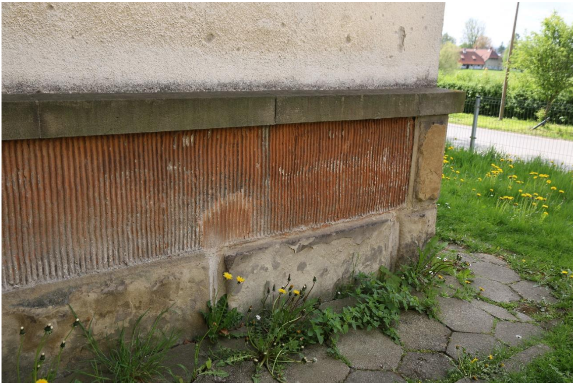
Fot. nr 18 Szpital Kliniczny im. Dr. J. Babińskiego w Krakowie, budynek nr 23. Elewacja północna. Zbliżenie części cokołowej. Widoczne zniszczenia tynków i kamienia. Stan przed konserwacją. Kraków, kwiecień 2023 r. fot. K. Sułkowska
