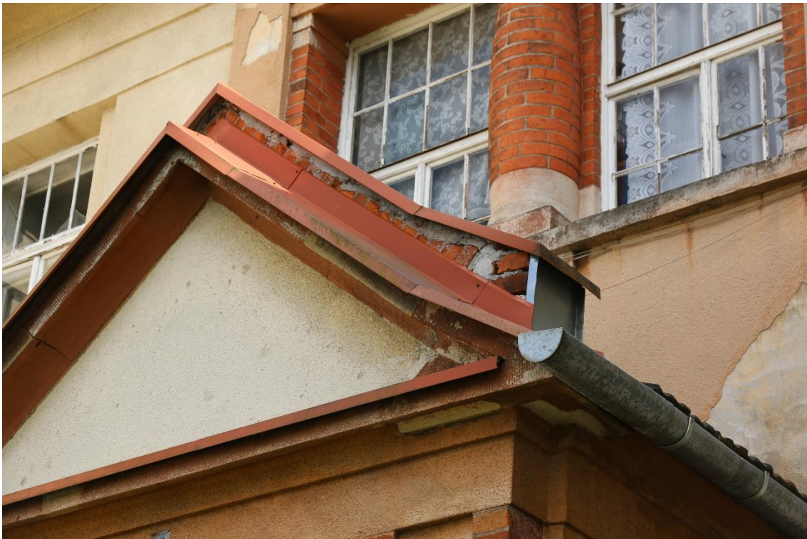
Fot. nr 10 Szpital Kliniczny im. Dr. J. Babińskiego w Krakowie, budynek nr 23. Zwieńczenie wejścia głównego do budynku. Widoczna powierzchnia tympanonu pokryta cementowym, barwionym nakropem. Tynkowany i ceglany gzyms pokryte wtórnym ofasowaniem blacharskim. Stan przed konserwacją. Kraków, kwiecień 2023 r.
