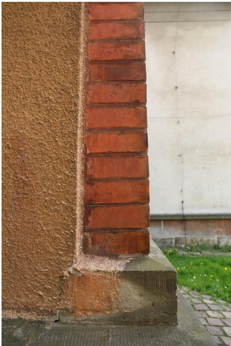
Fot. nr 7 Szpital Kliniczny im. Dr. J. Babińskiego w Krakowie, budynek nr 23. Fragment ceglanoego węgara po lewej stronie wejścia głównego do budynku. Widoczne resztki czerwonej warstwy malarskiej na powierzchni spoin. Stan przed konserwacją. Kraków, kwiecień 2023 r. fot. K. Sułkowska
