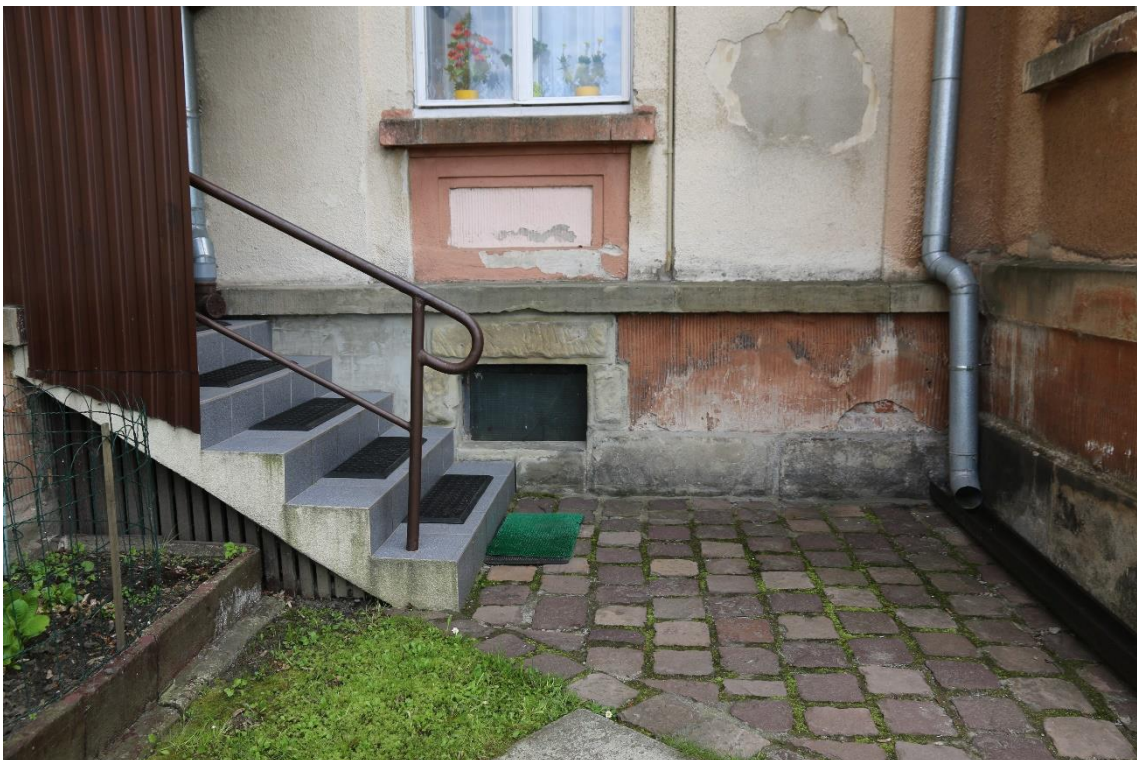
Fot. nr 15 Szpital Kliniczny im. Dr. J. Babińskiego w Krakowie, budynek nr 23. Elewacja północna. Zbliżenie dolnej części parteru. Widoczne zniszczenia tynków i kamienia. Stan przed konserwacją. Kraków, kwiecień 2023 r.
