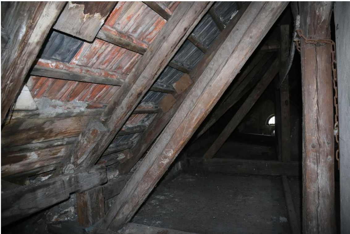
Fot. nr 42 Szpital Kliniczny im. Dr. J. Babińskiego w Krakowie, budynek nr 23. Strych. Widok pierwotnych dachówek w kolorze grafitowym. Widoczne wymienione dachówki w kolorze pomarańczowym oraz uszczelnienia połączeń zaprawą cementową. Stan przed konserwacją. Kraków, kwiecień 2023 r. fot. K. Sułkowska
