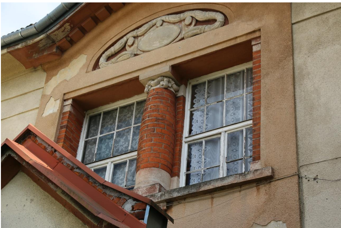
Fot. nr 11 Szpital Kliniczny im. Dr. J. Babińskiego w Krakowie, budynek nr 23. Zwieńczenie wejścia głównego do budynku w kondygnacji I piętra. Widoczna ceglana kolumna dzieląca okno, ozdobna dekoracja płyciny wykonana ze sztucznego kamienia. Stan przed konserwacją. Kraków, kwiecień 2023 r.
