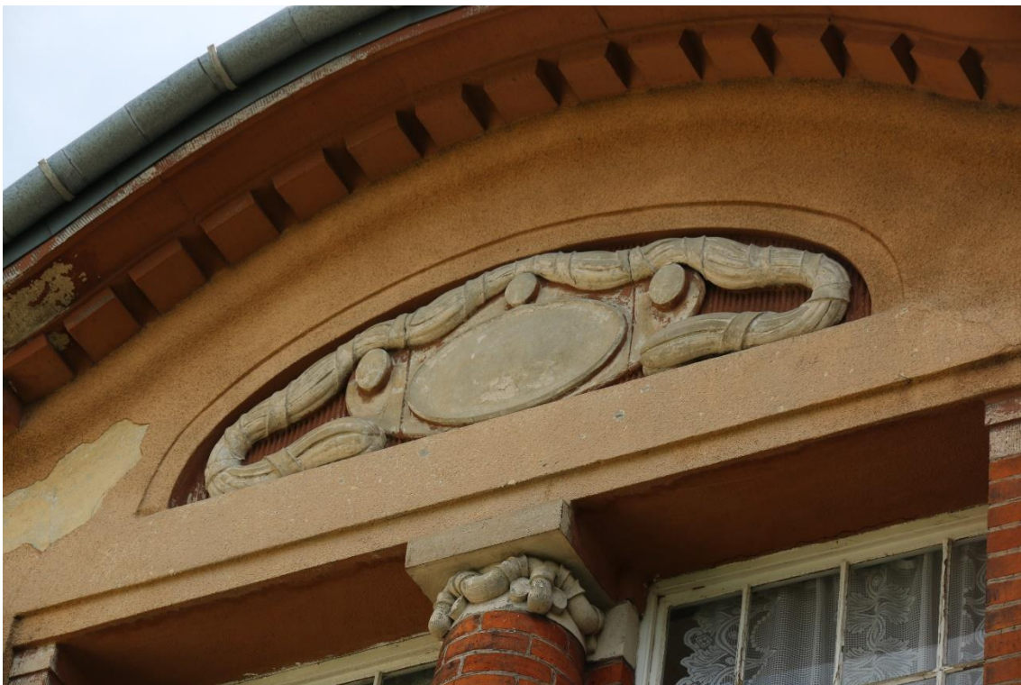
Fot. nr 12 Szpital Kliniczny im. Dr. J. Babińskiego w Krakowie, budynek nr 23. Elewacja północna. Zwieńczenie wejścia głównego do budynku w kondygnacji I piętra. Widoczna ozdobna dekoracja płyciny wykonana ze sztucznego kamienia. Stan przed konserwacją. Kraków, kwiecień 2023 r.
