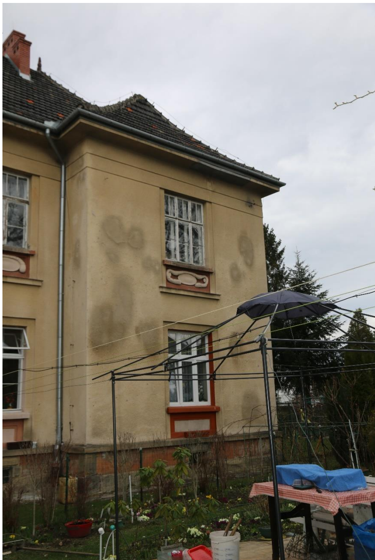
Fot. nr 31 Szpital Kliniczny im. Dr. J. Babińskiego w Krakowie, budynek nr 23. Widok ogólny prawego ryzalitu elewacji południowej. Widoczna zachowana pierwotna stolarka okienna na piętrze. Stan przed konserwacją. Kraków, kwiecień 2023 r.
