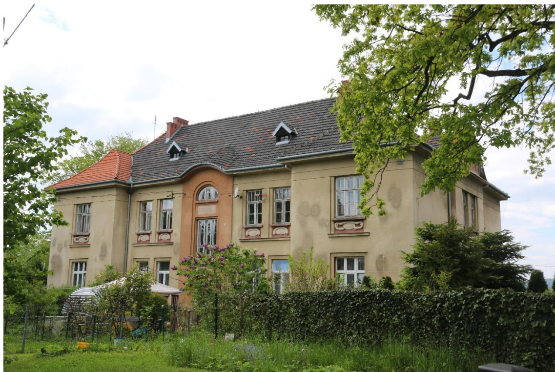
Fot. nr 26 Szpital Kliniczny im. Dr. J. Babińskiego w Krakowie, budynek nr 23. Widok ogólny elewacji południowej. Powierzchnia tynków zabrudzona i przemalowana. Część pokrycia dachowego od strony zachodniej wymieniona na nowe. Stan przed konserwacją. Kraków, marzec 2023 r. fot. K. Sułkowska
