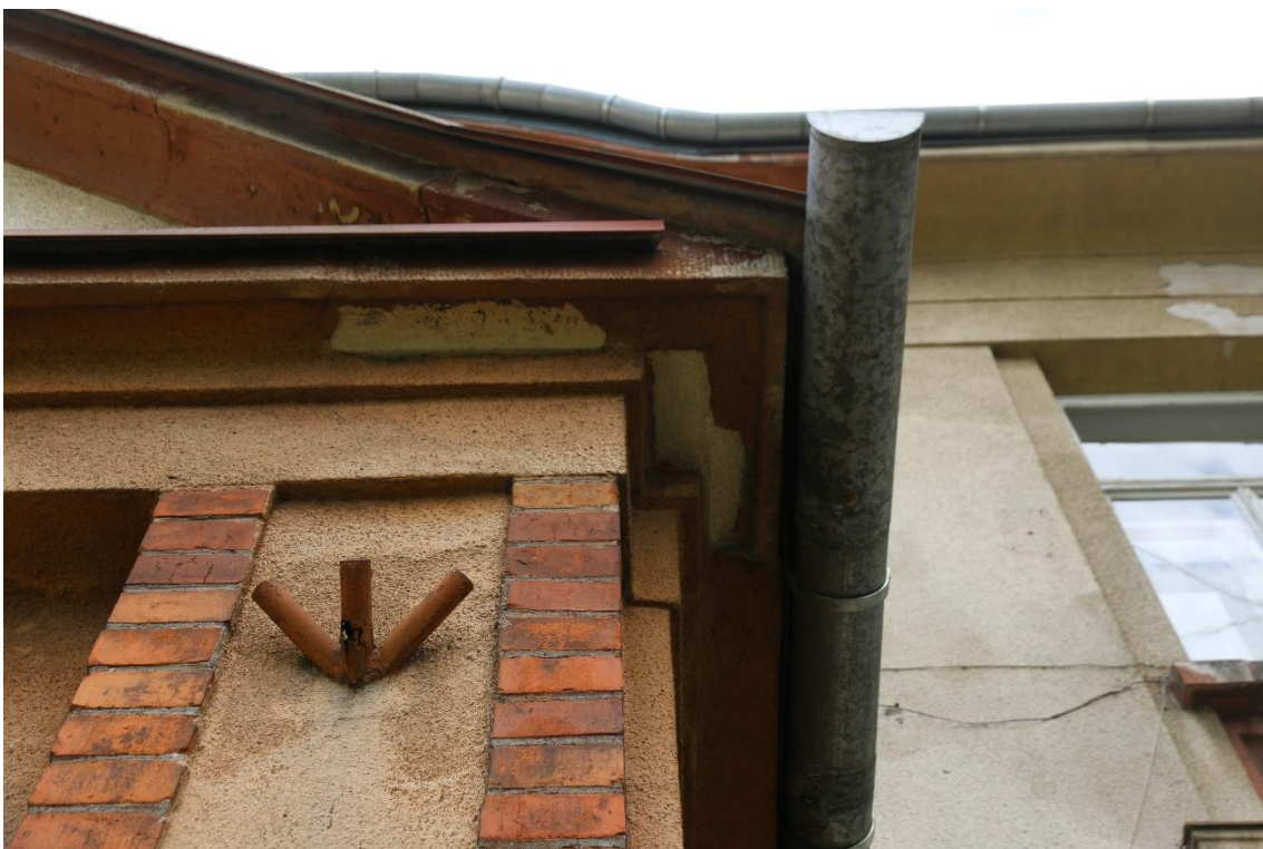
Fot. nr 9 Szpital Kliniczny im. Dr. J. Babińskiego w Krakowie, budynek nr 23. Fragment gzymsu wejścia głównego do budynku. Widoczna powierzchnia pokryta cementowym, barwionym nakropem. Stan przed konserwacją. Kraków, kwiecień 2023 r.
