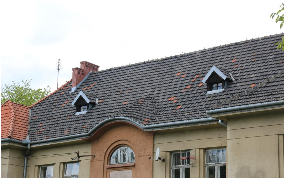
Fot. nr 28 Szpital Kliniczny im. Dr. J. Babińskiego w Krakowie, budynek nr 23. Widok ogólny środkowej, południowej połaci dachu. Widoczna zachowana pierwotna dachówka kolorze grafitowym. Stan przed konserwacją. Kraków, kwiecień 2023 r.
