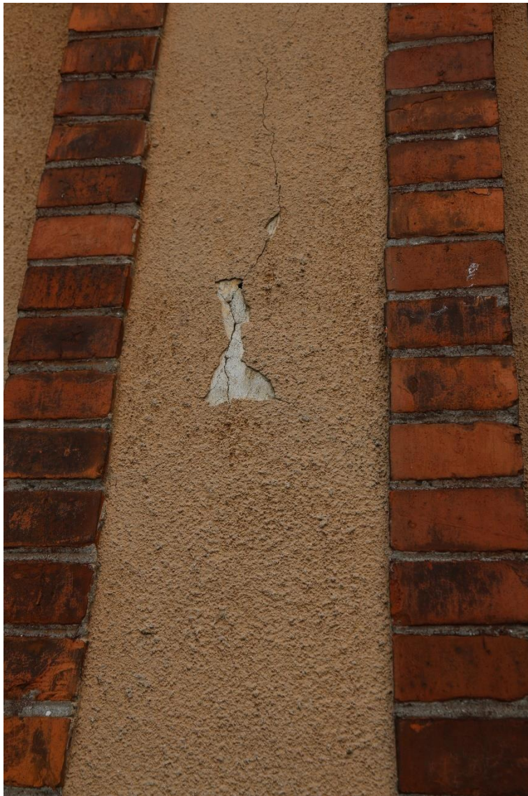
Fot. nr 6 Szpital Kliniczny im. Dr. J. Babińskiego w Krakowie, budynek nr 23. Fragment tynku po prawej stronie wejścia głównego do budynku. Widoczna naturalna odkrywka tynku z jasnoszarą pierwotną warstwą malarską. Stan przed konserwacją. Kraków, kwiecień 2023 r. fot. K. Sułkowska
