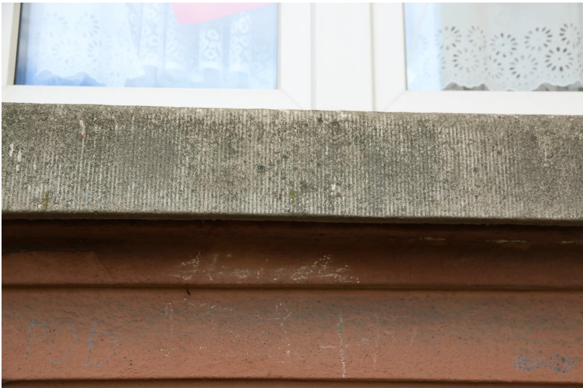
Fot. nr 17 Szpital Kliniczny im. Dr. J. Babińskiego w Krakowie, budynek nr 23. Elewacja północna. Zbliżenie parapetu okna parteru. Widoczna pierwotna prążkowana faktura odlewu betonowego. Stan przed konserwacją. Kraków, kwiecień 2023 r. fot. K. Sułkowska
