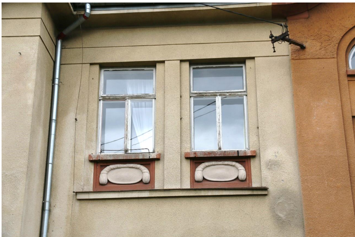
Fot. nr 29 Szpital Kliniczny im. Dr. J. Babińskiego w Krakowie, budynek nr 23. Widok okien I piętra środkowej części elewacji południowej. Widoczna wymieniona stolarka okienna z innym podziałem kwater. Stan przed konserwacją. Kraków, marzec 2023 r.
