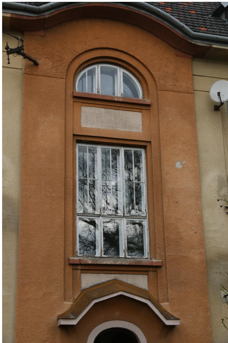
Fot. nr 46 Szpital Kliniczny im. Dr. J. Babińskiego w Krakowie, budynek nr 23. Pierwotna stolarka okienna klatki schodowej. Stan przed konserwacją. Kraków, kwiecień 2023 r. fot. K. Sułkowska
