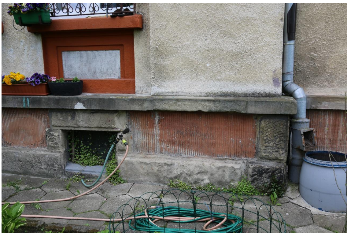
Fot. nr 34 Szpital Kliniczny im. Dr. J. Babińskiego w Krakowie, budynek nr 23. Elewacja wschodnia. Widok cokołu. Widoczne zachowane ryflowane tynki oraz zabrudzona powierzchnia kamienia. Stan przed konserwacją. Kraków, kwiecień 2023 r.
