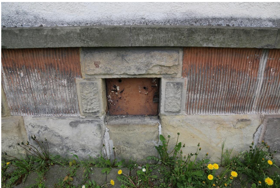
Fot. nr 37 Szpital Kliniczny im. Dr. J. Babińskiego w Krakowie, budynek nr 23. Elewacja północna. Widok cokołu. Widoczne ryflowane tynki oraz zabrudzona powierzchnia kamienia. Stan przed konserwacją.
