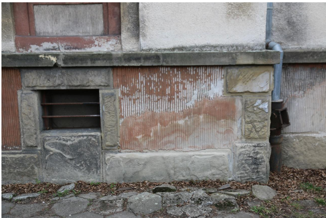
Fot. nr 25 Szpital Kliniczny im. Dr. J. Babińskiego w Krakowie, budynek nr 23. Widok części cokołowej elewacji zachodniej. Widoczne zniszczenia tynków i kamienia. Stan przed konserwacją. Kraków, marzec 2023 r. fot. K. Sułkowska
