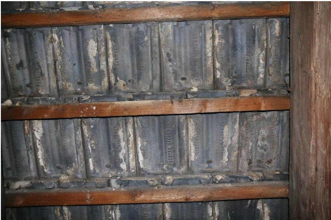
Fot. nr 40 Szpital Kliniczny im. Dr. J. Babińskiego w Krakowie, budynek nr 23. Strych. Widok pierwotnych dachówek w kolorze grafitowym z wytłoczonym napisem „PŁASZOWSKA FABRYKA DACHÓWEK”. Stan przed konserwacją. Kraków, kwiecień 2023 r.
