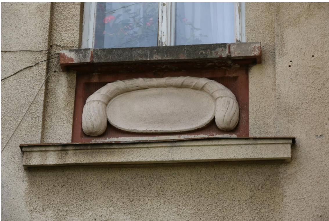
Fot. nr 13 Szpital Kliniczny im. Dr. J. Babińskiego w Krakowie, budynek nr 23. Elewacja północna. Zbliżenie okna w kondygnacji I piętra. Widoczna ozdobna dekoracja płyciny wykonana ze sztucznego kamienia, przemalowana. Stan przed konserwacją. Kraków, kwiecień 2023 r.
