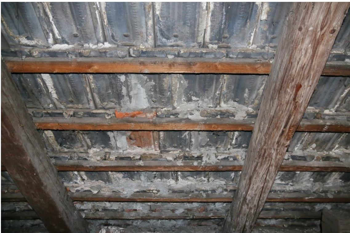
Fot. nr 41 Szpital Kliniczny im. Dr. J. Babińskiego w Krakowie, budynek nr 23. Strych. Widok pierwotnych dachówek w kolorze grafitowym. Widoczna wymieniona dachówka w kolorze pomarańczowym oraz uszczelnienia połączeń zaprawą cementową. Stan przed konserwacją. Kraków, kwiecień 2023 r.
