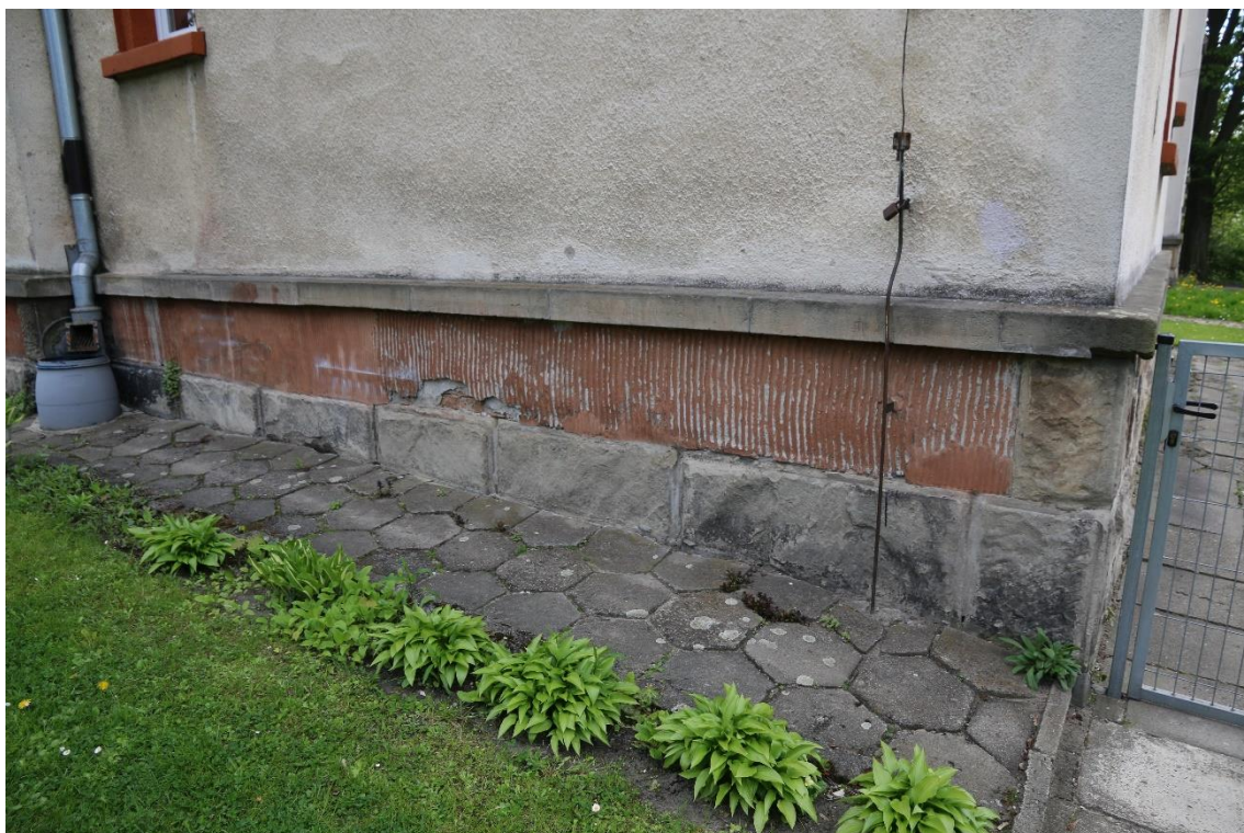
Fot. nr 35 Szpital Kliniczny im. Dr. J. Babińskiego w Krakowie, budynek nr 23. Elewacja wschodnia. Widok cokołu. Widoczne naprawiane ryflowane tynki oraz zabrudzona powierzchnia kamienia. Stan przed konserwacją. Kraków, kwiecień 2023 r.
