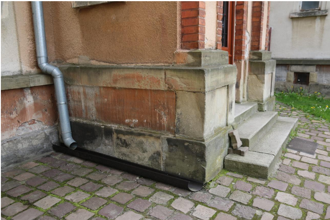
Fot. nr 8 Szpital Kliniczny im. Dr. J. Babińskiego w Krakowie, budynek nr 23. Cokół po lewej stronie wejścia głównego do budynku. Widoczny cokół i gzyms z piaskowca oraz ryflowane tynki pomiędzy nimi. Stan przed konserwacją. Kraków, kwiecień 2023 r.
