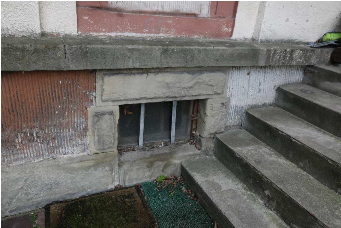
Fot. nr 16 Szpital Kliniczny im. Dr. J. Babińskiego w Krakowie, budynek nr 23. Elewacja północna. Zbliżenie cokołu parteru. Widoczne pierwotne ryflowane tynki. Stan przed konserwacją. Kraków, kwiecień 2023 r. fot. K. Sułkowska
