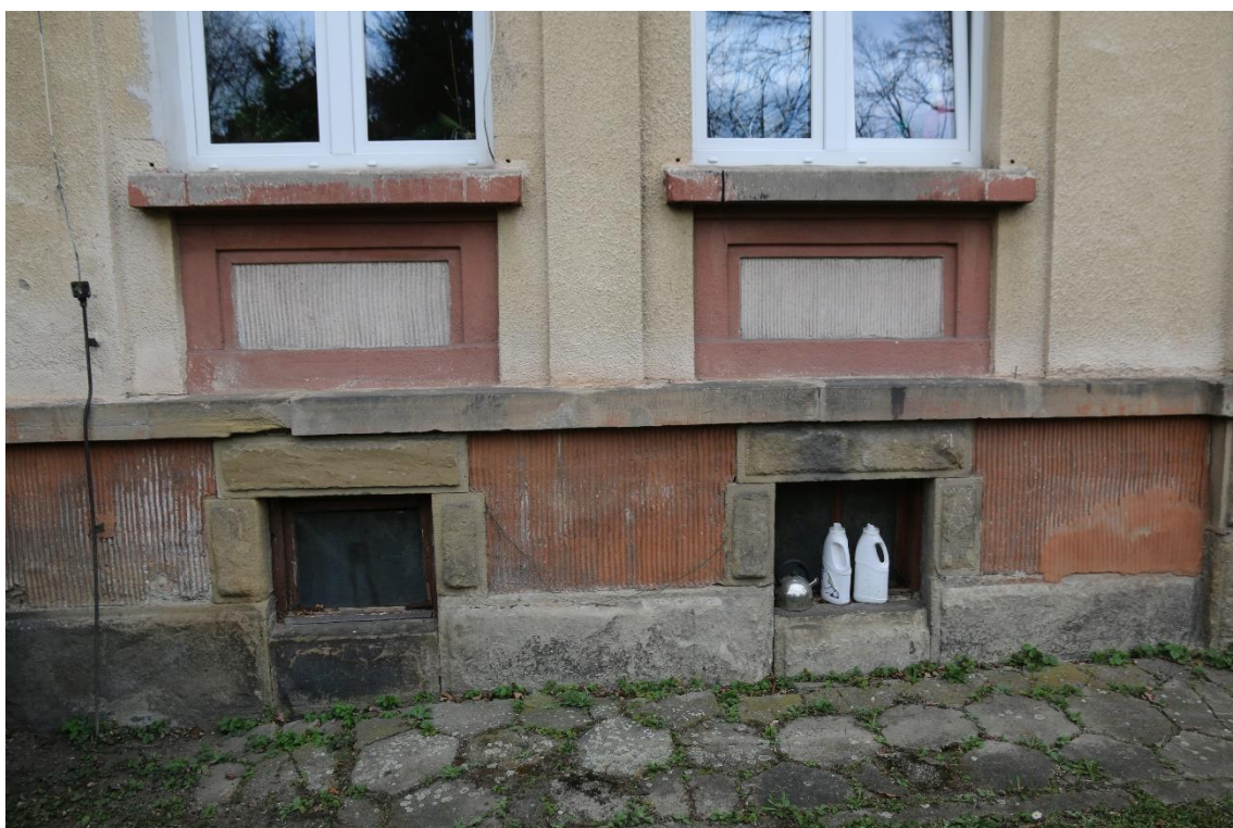
Fot. nr 30 Szpital Kliniczny im. Dr. J. Babińskiego w Krakowie, budynek nr 23. Widok cokołu środkowej części elewacji południowej. Widoczna zachowana pierwotna forma ryflowanych tynków. Stan przed konserwacją. Kraków, marzec 2023 r.
