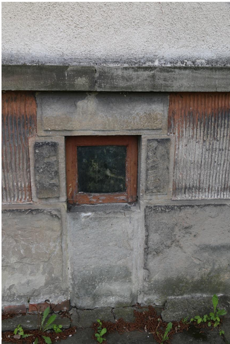
Fot. nr 38 Szpital Kliniczny im. Dr. J. Babińskiego w Krakowie, budynek nr 23. Elewacja północna. Widok cokołu. Widoczne ryflowane tynki oraz zabrudzona powierzchnia kamienia. Stan przed konserwacją. Kraków, kwiecień 2023 r.
