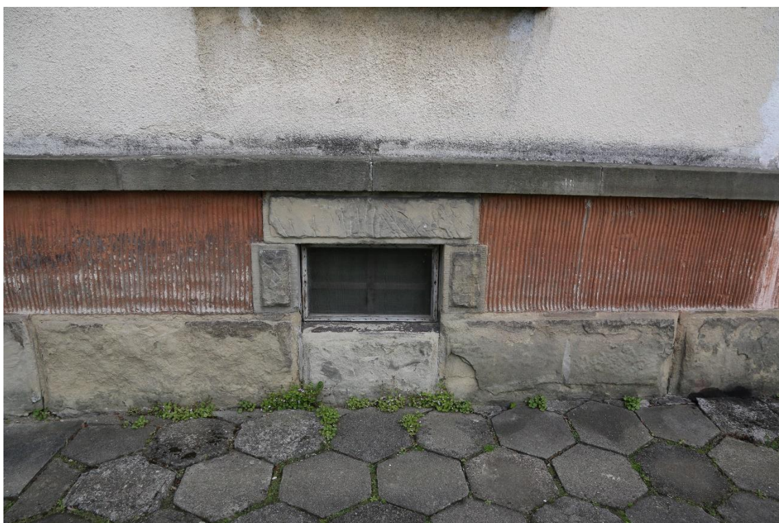
Fot. nr 36 Szpital Kliniczny im. Dr. J. Babińskiego w Krakowie, budynek nr 23. Elewacja północna. Widok cokołu. Widoczne naprawiane ryflowane tynki oraz zabrudzona powierzchnia kamienia. Stan przed konserwacją. Kraków, kwiecień 2023 r.
