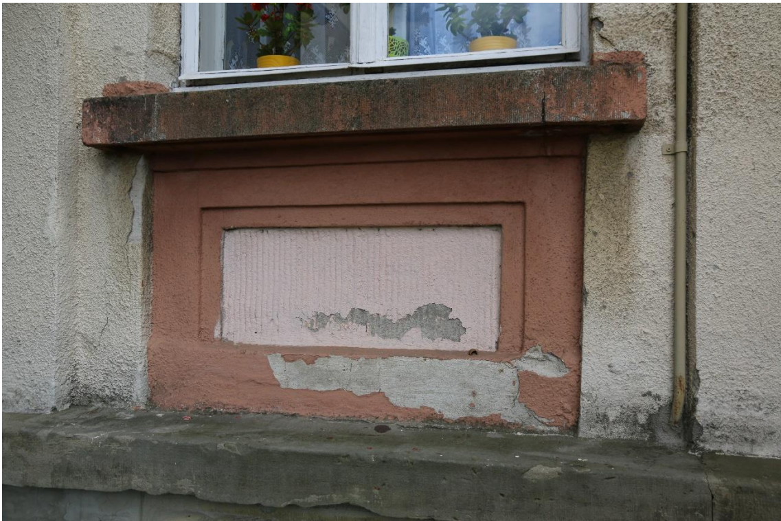
Fot. nr 14 Szpital Kliniczny im. Dr. J. Babińskiego w Krakowie, budynek nr 23. Elewacja północna. Zbliżenie okna w kondygnacji parteru. Widoczna ozdobna dekoracja płyciny wykonana z ryflowanego tynku, przemalowana. Stan przed konserwacją. Kraków, kwiecień 2023 r.
