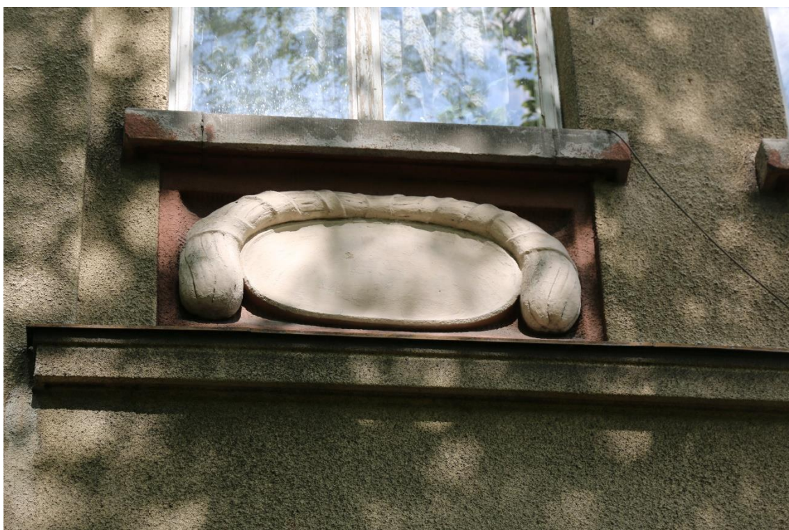
Fot. nr 24 Szpital Kliniczny im. Dr. J. Babińskiego w Krakowie, budynek nr 23. Elewacja zachodnia. Zbliżenie okna w kondygnacji I piętra. Widoczna ozdobna dekoracja płyciny wykonana ze sztucznego kamienia, przemalowana. Stan przed konserwacją.
