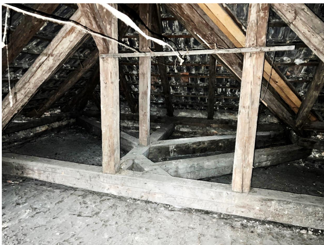
Fot. 9 Układ tramów w części skrzydłowej budynku
