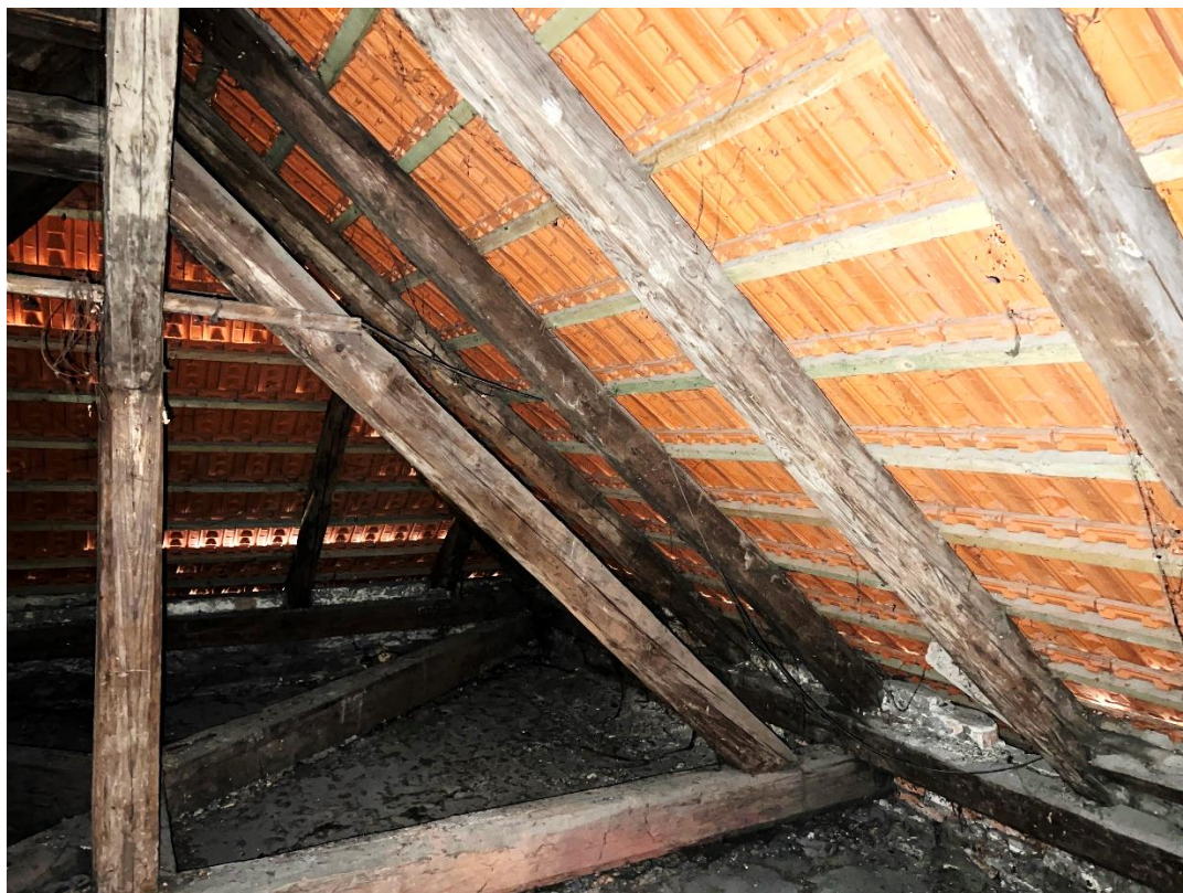
Fot. 4 Widok połaci z wymienioną dachówką
