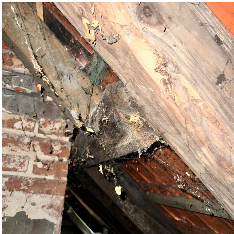
Fot. 11 Nieprawidłowe, uszkodzone mocowanie wymianów
