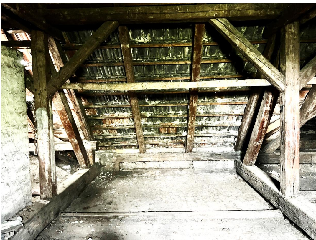
Fot. 5 Widok połaci z niewymienioną dachówką
