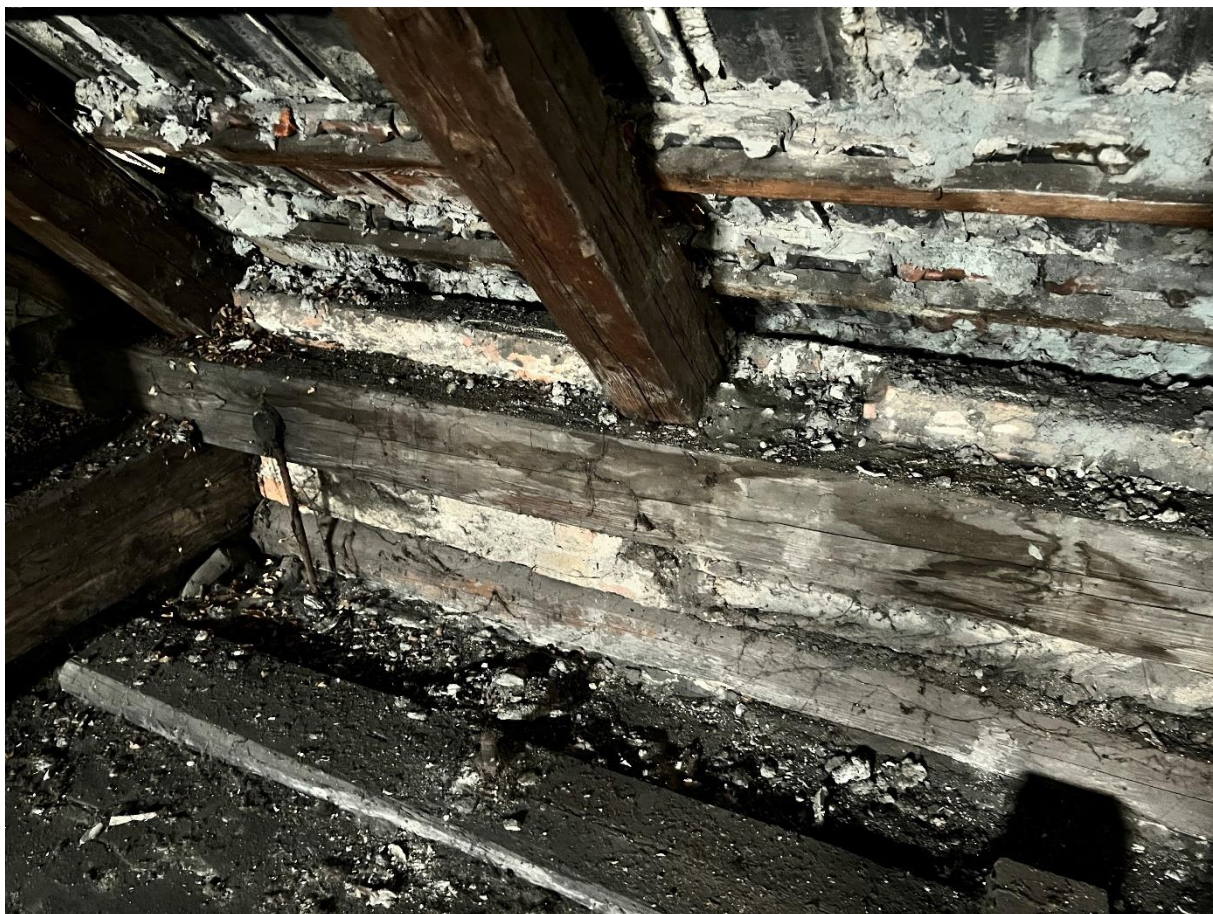
Fot. 10 Oparcie belki drewnianej w okolicy muru ścianki kolankowej
