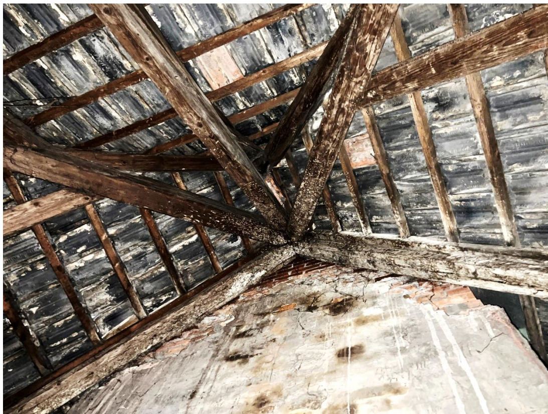
Fot. 6 Widok elementów porażonych korozją biologiczną w rejonie komina
