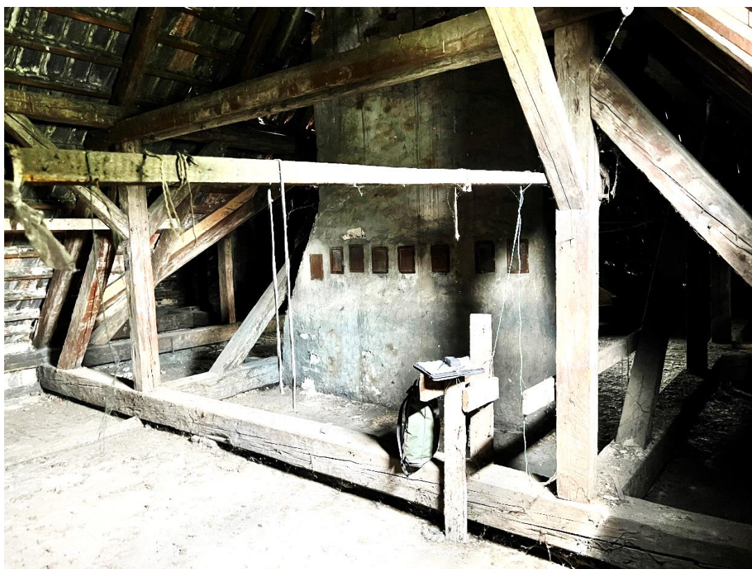
Fot. 8 Widok wiązara wieszarowego w części frontowej
